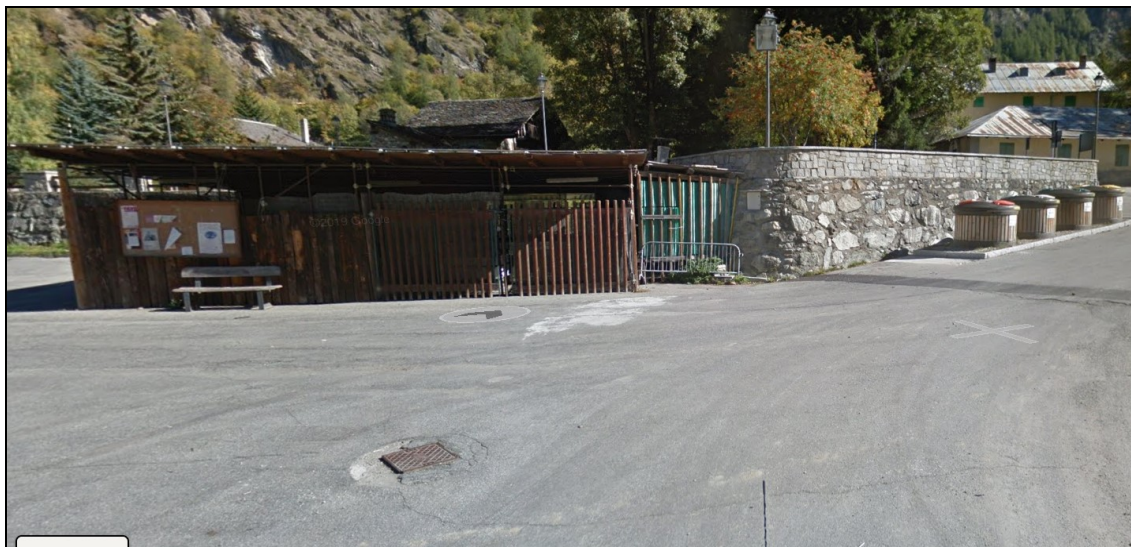
Foto 9: AREA OSPITERÀ LA CABINA DI CONSEGNA (FONTE GOOGLE MAPS)
